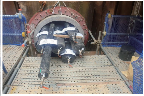
PE Pipe Pulling
