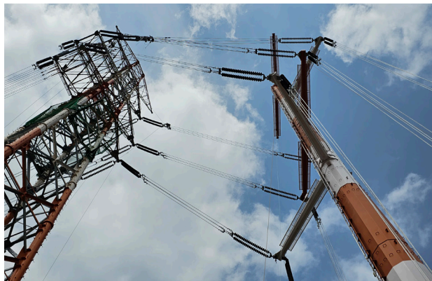
울산 GPS CCPP Project 송전선로공사 [울산지피에스]
