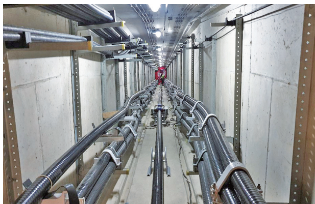
154kV 달성~월배 지중 TL 건설사업 [한국전력공사]
