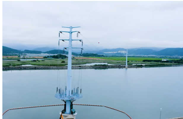
154kV 광양항-울산TL 건설공사 [한국전력공사]
