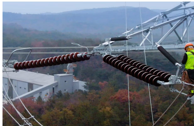
여주 천연가스발전소 건설공사 중 345kV 가공송전선로공사 [여주에너지서비스]
