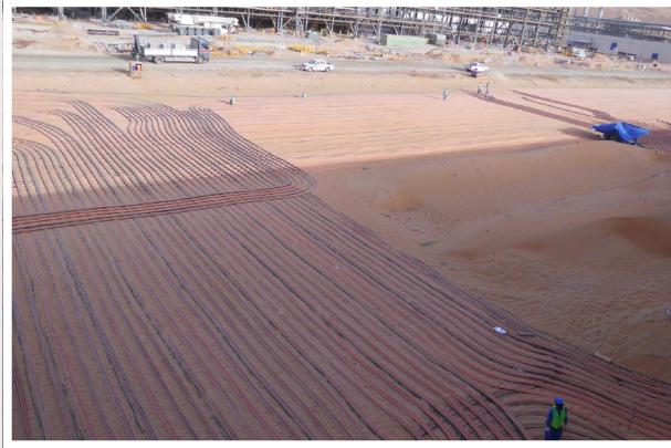
HV Cable Pulling
