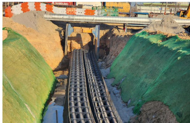
울산 SKMU Project OBL 지중송전선로공사 [SK멀티유틸리티]
