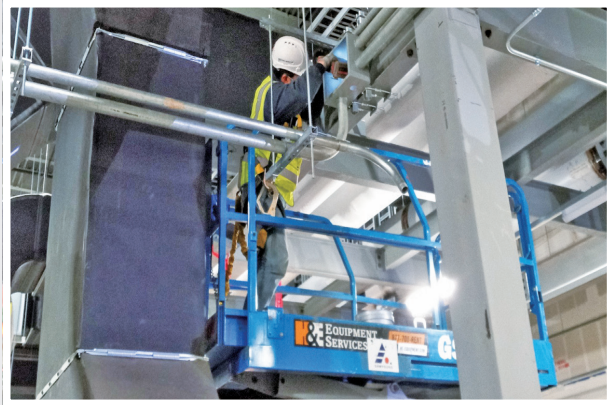
Steel Conduit installtion
