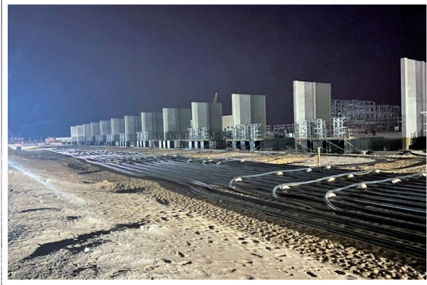
EHV Cable Pulling
