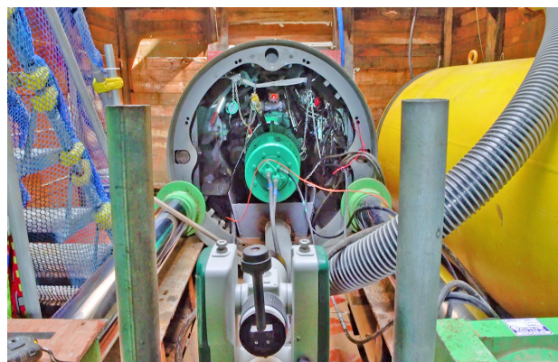
SK Hynix 전력 INFRA 확보공사-Semi-Shield [SK 하이닉스]
